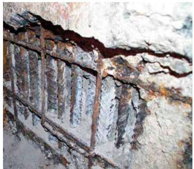
Schäden an der Stahlbetonstruktur durch Chlorideinwirkung
